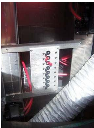
12 Volt circuit breakers
